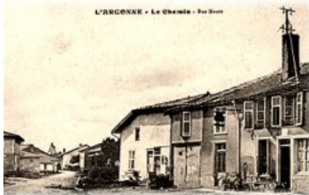
Carte postale : Le début de la Rue Haute vers 1910 ; on notera que l'ancien café à droite était alors seul dans la rue à posséder l'électricité (potence fixée à la cheminée).
