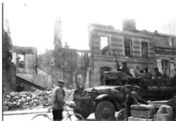
Une maison incendiée rue P. de la Force. Les pierres à droite sont celle du jardin de l'hôtel de ville.
