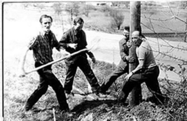
Remplacement d'un support BT à la zone industrielle Ste Menou De gauche à droite : Marcel Vuillaume, Gérard Selhum, René Delaval, Hubert Ferrette.
