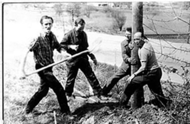
Remplacement d'un support BT à la zone industrielle Ste Menou De gauche à droite : Marcel Vuillaume, Gérard Selhum, René Delaval, Hubert Ferrette.
