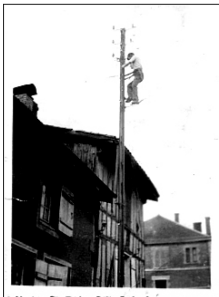
A Givry le 18 août 1946 Raccordement d'un branchement provisoire
